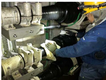
ケーブル外観点検
