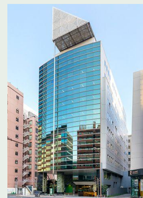
住友電設ビル
