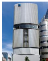
ヒューリック 銀座ワールド タウンビル 82億円
