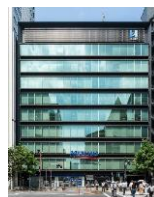
ヒューリック 麹町ビル 133億円
