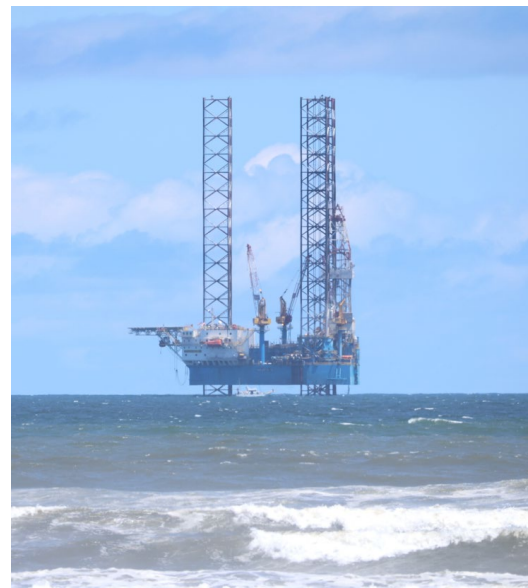
首都圏CCS 掘削リグ“HAKURYU-10”
