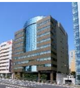
プライム 新横浜ビル
