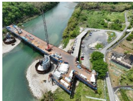
第二木曽川橋りょう ケーソン工
