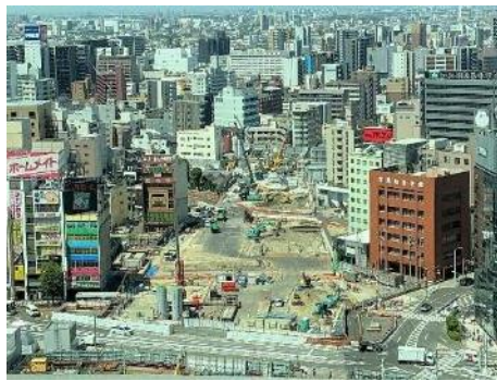
名古屋駅（西工区） 全景
