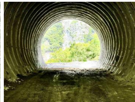
南アルプストンネル (山梨工区) 本坑・品川方貫通
