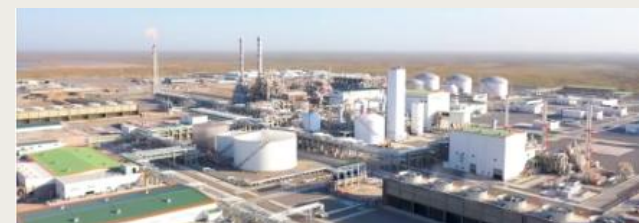
当社がトルクメニスタンで建設した Gas to Gasolineプラント 生産量：60万ton/年
