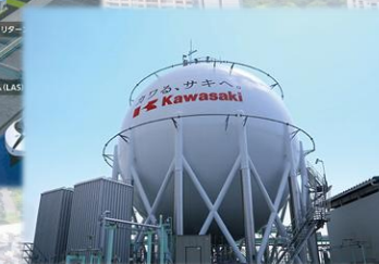
液化水素タンク
