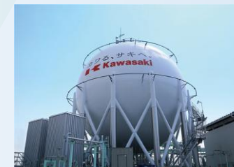
液化水素タンク
